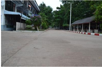
ถนน ถนนคอนกรีต ปีที่สร้าง 2538
