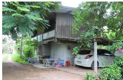
บ้านพักครู 203/27 ปีที่สร้าง 2525
