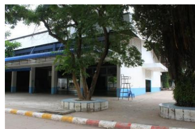
อาคารอเนกประสงค์ อาคารหอประชุม 100/27 ปีที่สร้าง 2523
