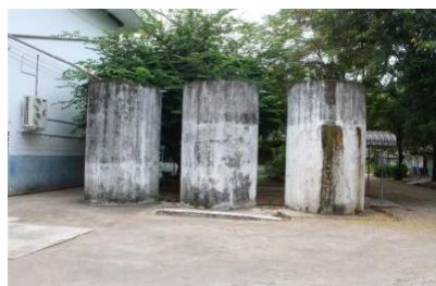
ถังเก็บน้ำ ฝ.33 ปีที่สร้าง 2521
