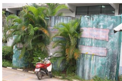
ถังเก็บน้ำ ฝ.33 ปีที่สร้าง 2536
