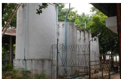
ถังเก็บน้ำ ฝ.33 ปีที่สร้าง 2531
